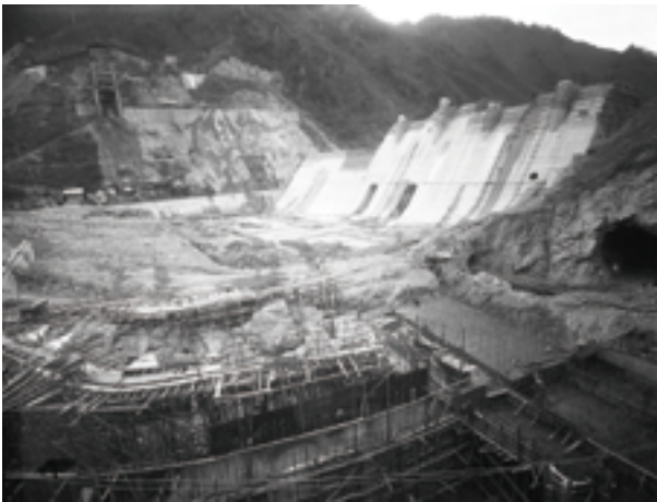
山崎治雄 建設中の旭川ダム 岡山県 1952年ごろ
