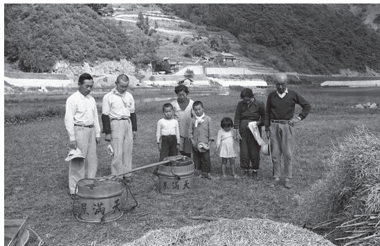
「田んぼとお別れ」旭川ダムの発電所工事 1954年頃 (撮影：山崎治雄)
