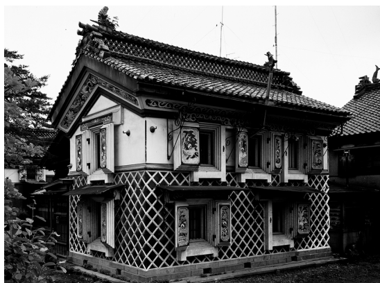
サフラン酒造の土蔵(新潟県長岡市)
