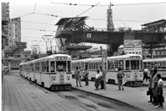
諸河久 都電 渋谷駅前首都高速3号線の工事中
