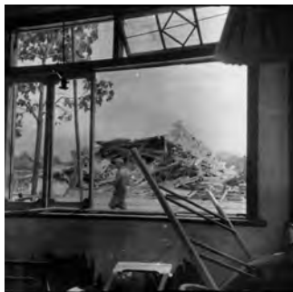
④ 午後 2 時ごろ、爆風で吹き飛んだ窓枠。
