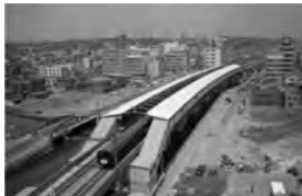
撮影者・浅野隆、撮影年月日・1964 年(推定)、撮影場所・神奈川県横浜市中区 横浜市庁舎
