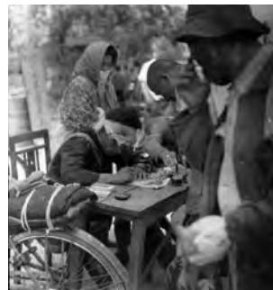
⑤ 午後 4 時過ぎ、爆心地から南東約外の倒壊した建物は西消防署皆実出張所。2.3 キロの広島地方専売局前、被災者に「罹災証明書」を書く宇品署の警察官。『LIFE』誌に 1 頁大で掲載される。
